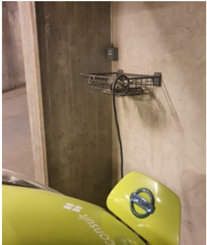
Kurv for oppbevaring av styringsboks. Det anbefales at slike løsninger fases ut.
